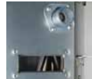
Kondenzvíz ellenőrző nyílás
